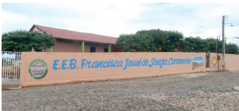
Foto 1- Fachada da escola Fonte: arquivo pessoal.
