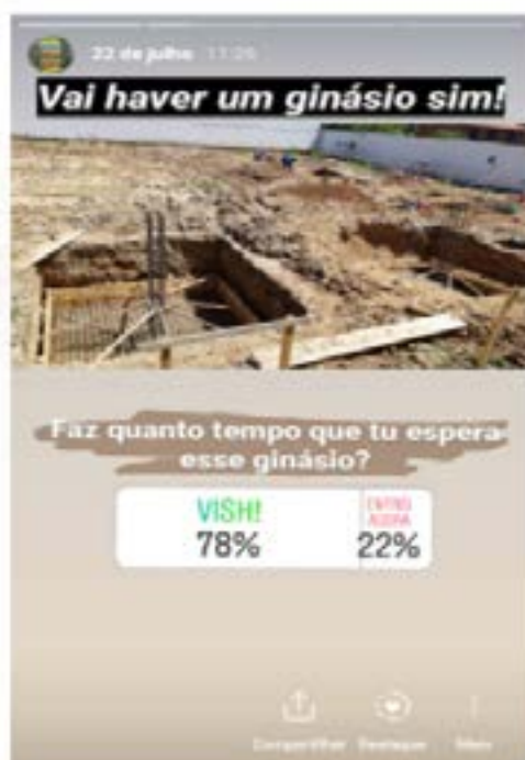
Figura 4 - Construção da quadra poliesportiva da escola
