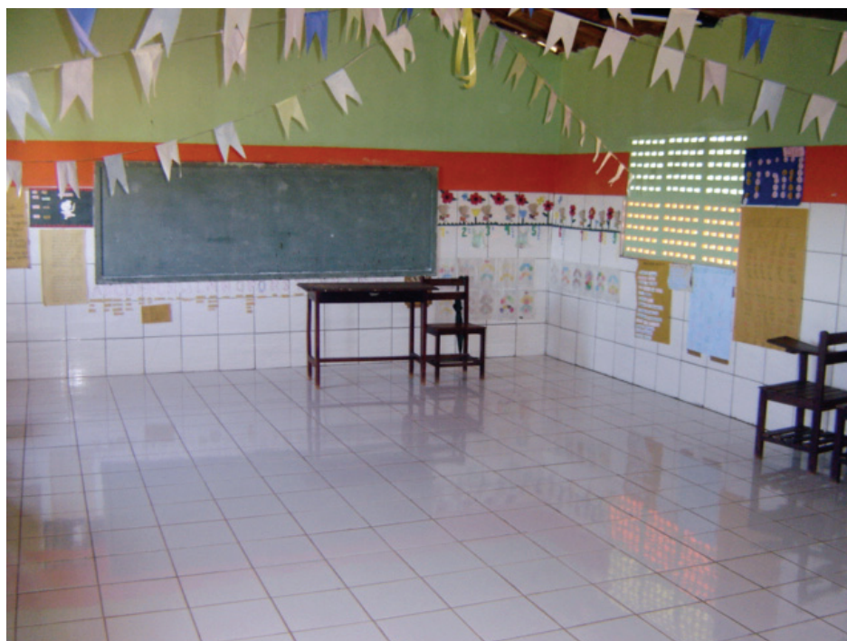
Foto 3: Sala de aula reformada em município do PRODEM.
