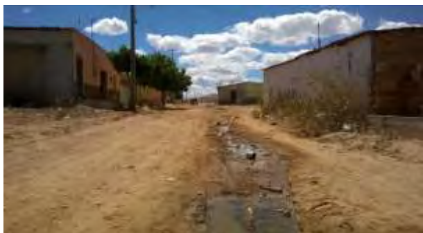
Figura 08: Rua sem pavimentação e saneamento básico no Bairro Guarani em Campos Sales, Ceará
