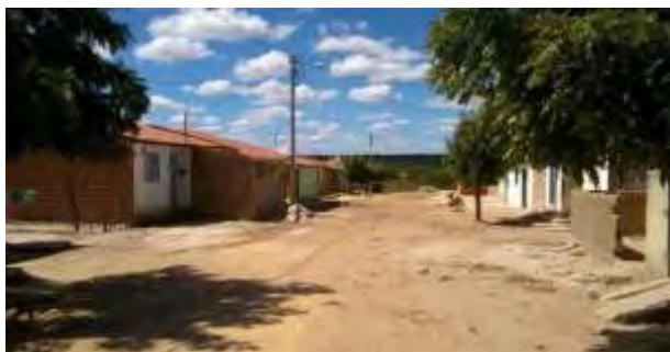
Figura 06: Rua sem pavimentação e saneamento básico no Bairro Poço em Campos Sales, Ceará
