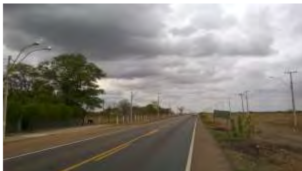
Figura 09: Trecho da CE - 292 que liga Campos Sales, CE a Fronteiras, PI, com sua eficiente iluminação pública em vazios urbanos
