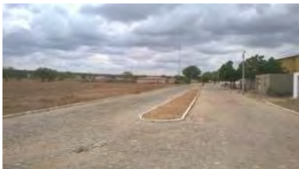
Figura 13: Pavimentação em loteamento situado em "área nobre" e pouco habitada da cidade de Campos Sales, Ceará
